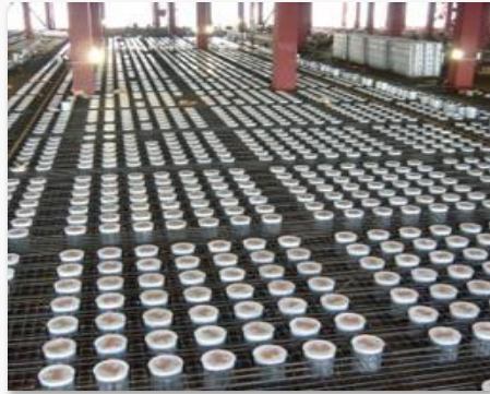
Grid Precast waffle slab
