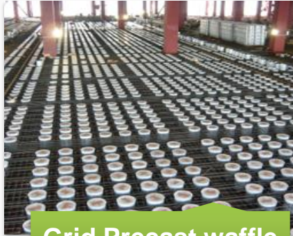
Grid Precast waffle slab
